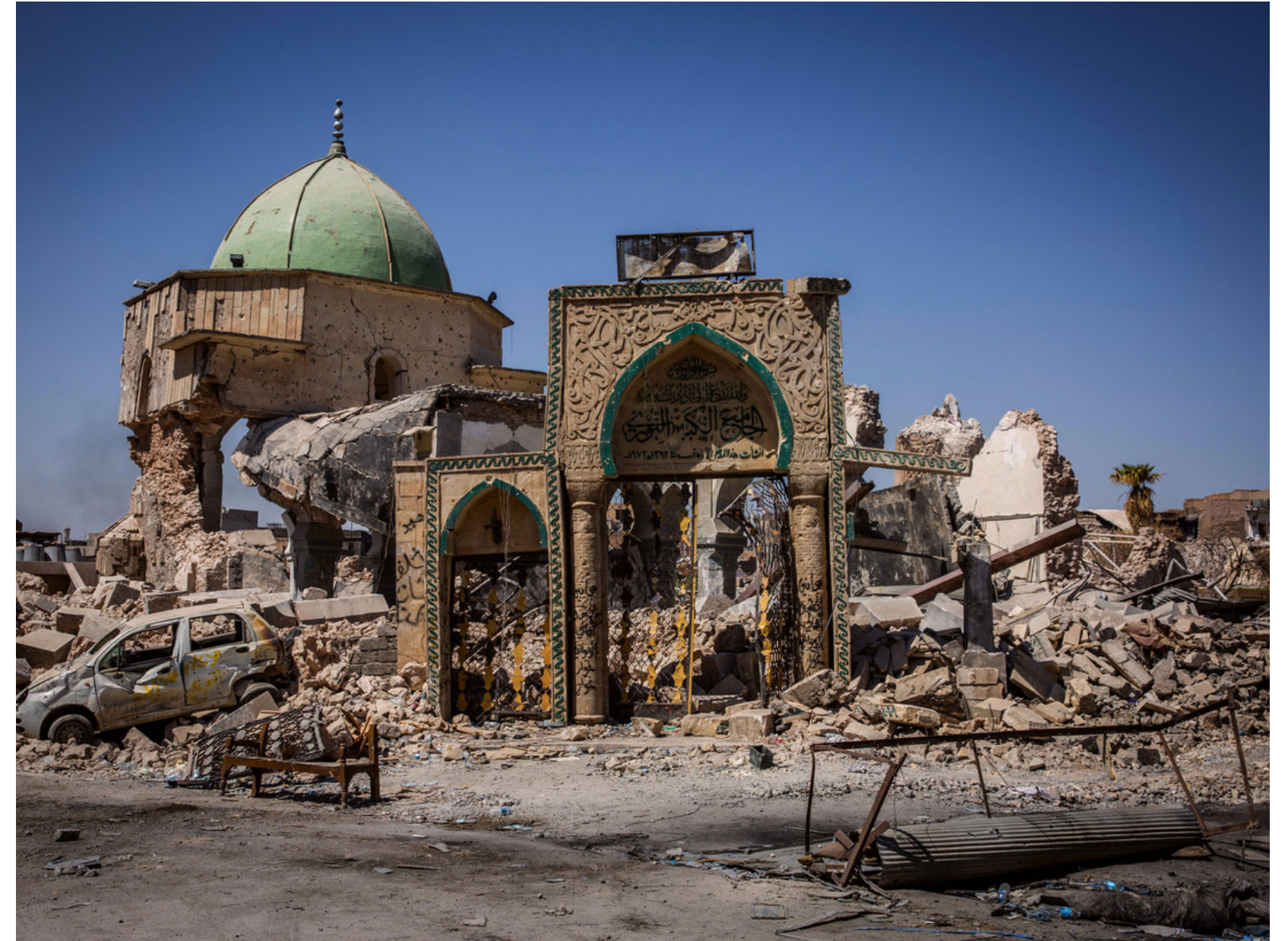
LA GRANDE MOSCHEA DI AL-NURI DISTRUTTA - MOSUL, 7 AGO 2017
